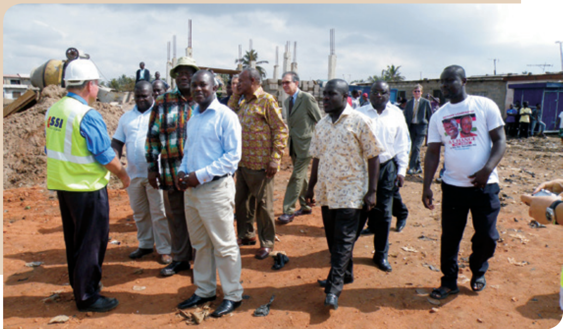
在加纳首都某城市排污项目现场陪同世界银行代表在开工典礼时视察现场
