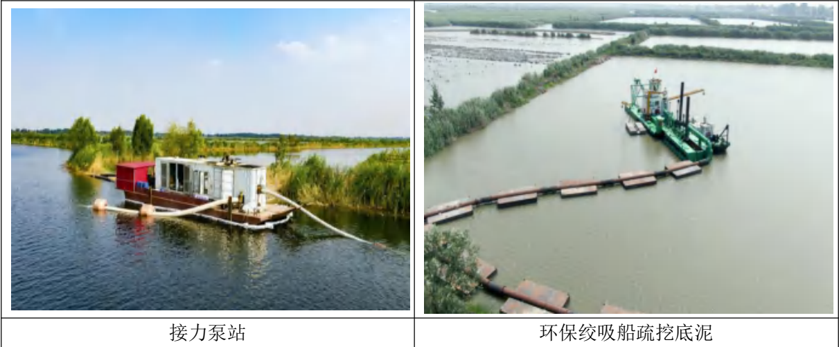
图 3-4 底泥疏挖输送工艺流程
