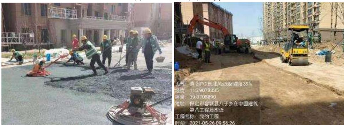
图2-10 透水道路施工
