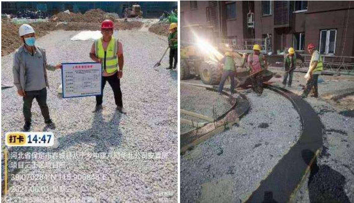
图2-11 透水砖铺装施工
