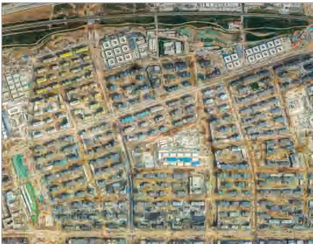
图2-5 D1组团现状航拍照片
