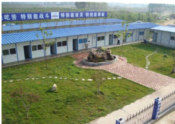
图 5-7 施工生产生活区
