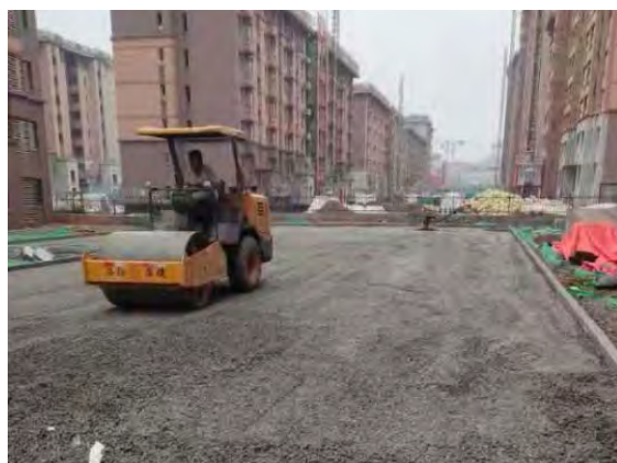
图2-5 透水砖铺装施工
